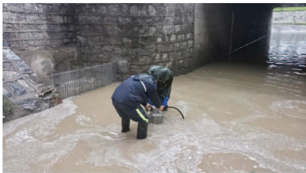
王佐镇佃起村南岗洼涵洞排水作业
